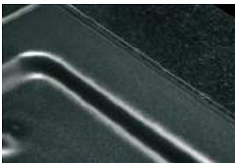
Siliconer : le lissage ultérieur de la silicone après l'application laisse un joint étanche et pratiquement invisible entre la pierre naturelle et la céramique.
