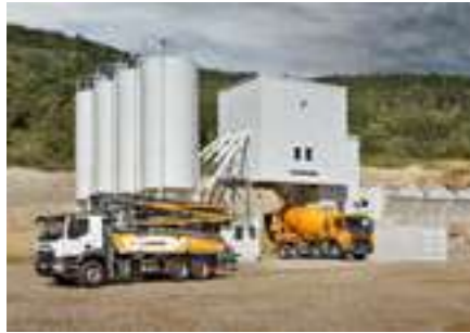
Technique du béton
